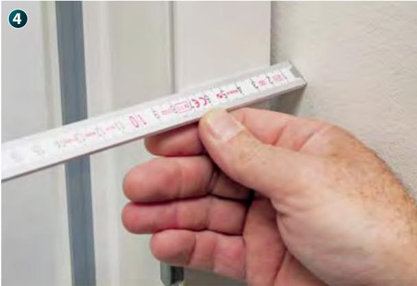
首先，测量并确定接缝宽度。
