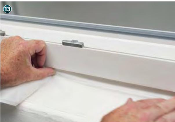
密封底部接缝，请拆下窄条并将胶带压到窗户外框上。
