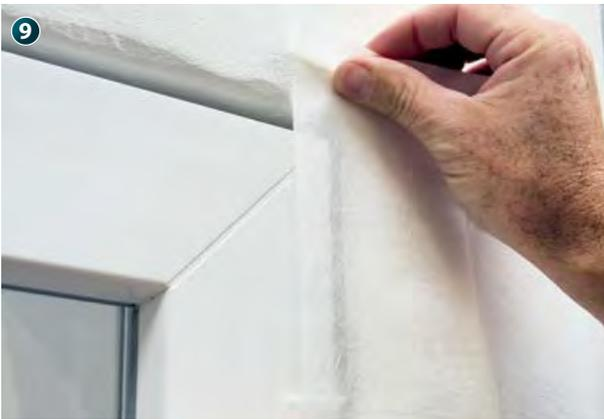
使用湿度可变的Hanno®防水薄膜胶带，您可以对内部和外部的接缝连接处进行密封。
