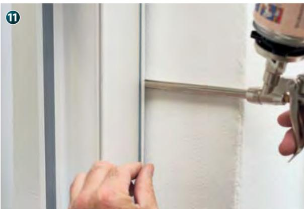
现在，接缝可以完全填充合适的填充材料。
